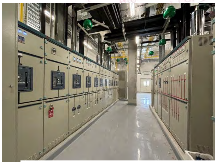
รูปที่ MDB ห้องไฟฟ้า (ต้นทาง)
